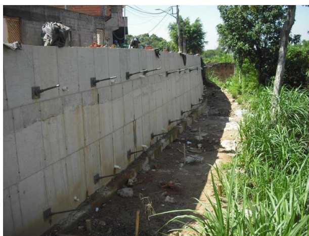
Figura 156 – Estacas HCM
