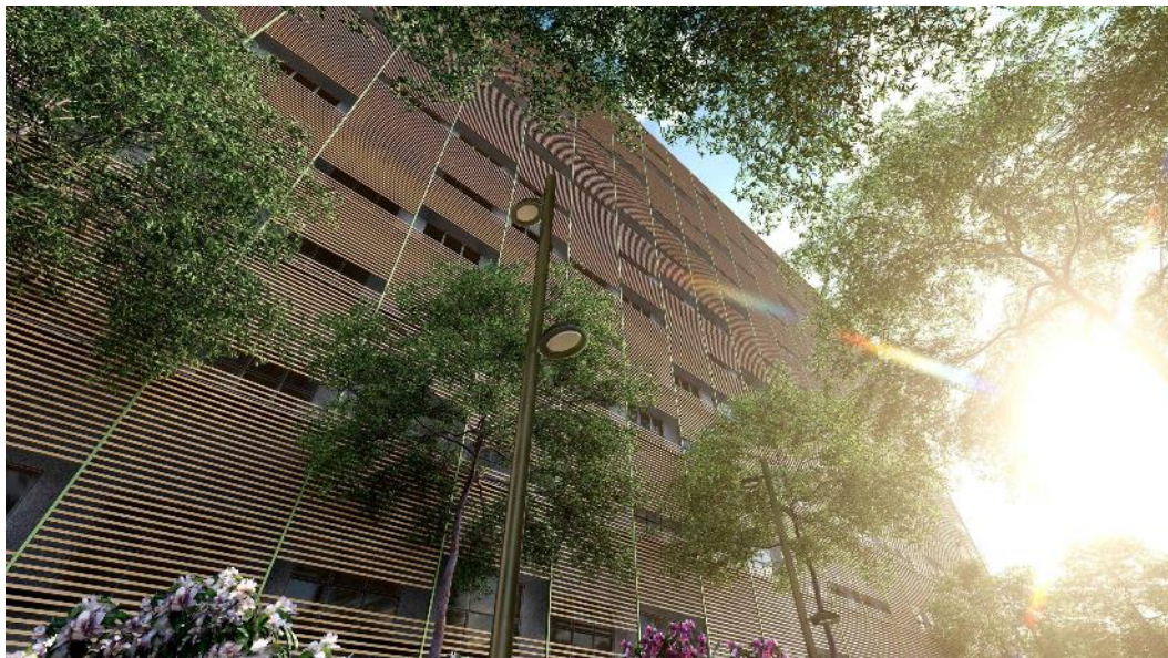
Figura 69 – Fachada sul do Bloco 03
